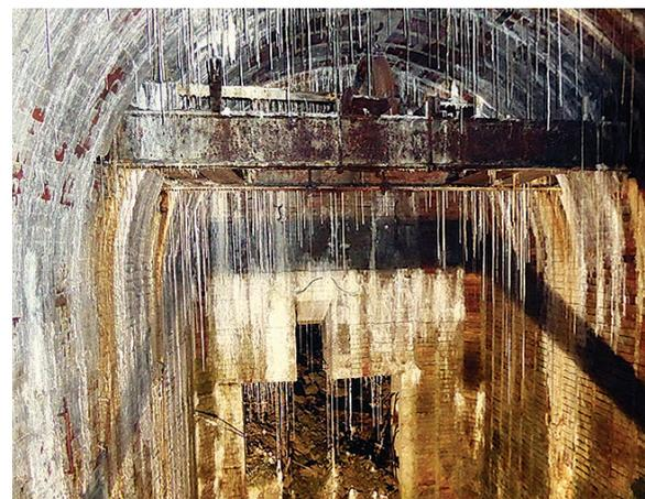
Рис. 5. Натечные образования в вертикальной шахте бункеров Оберзальцберга.
