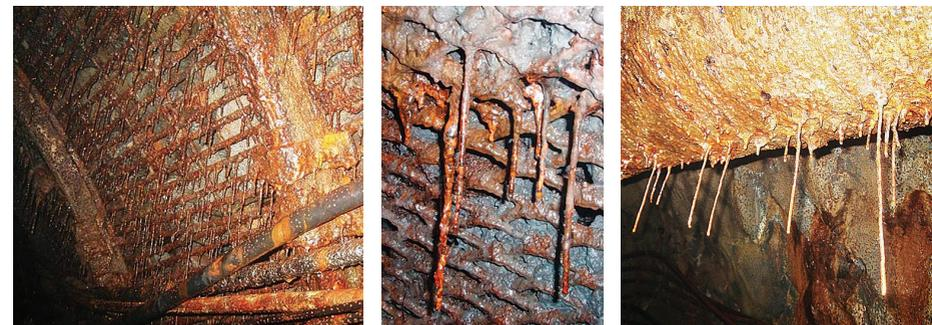
Рис. 1. Железистые сталактиты в квершлага № 1 на металлической арматуре арочной крепи (слева), сетке-стяжке (в центре), воздуховоде (справа).
