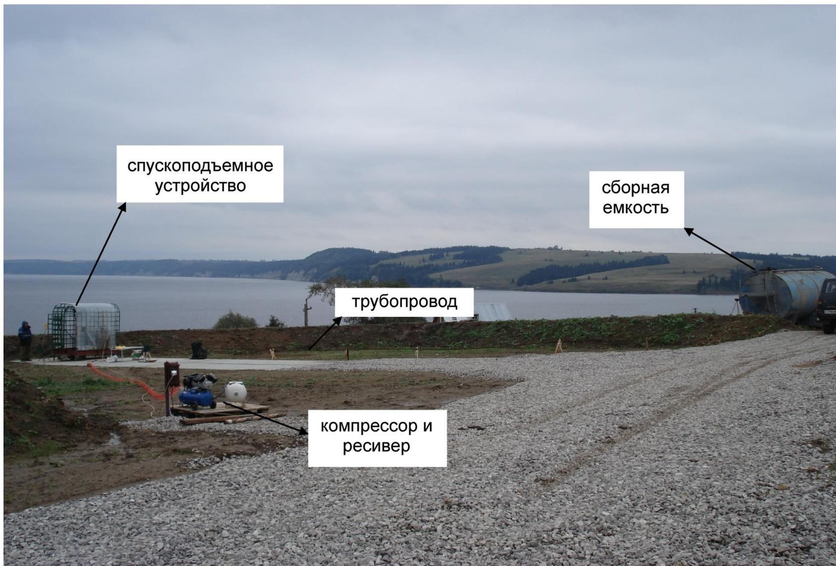
Рисунок 4.1 – Насосное оборудование, при помощи которого была произведена откачка нефтепродуктов из скважины СС-3
