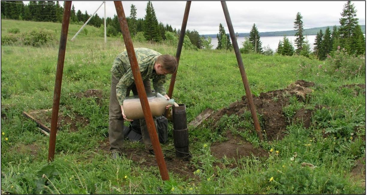
Рисунок 4.5 – Заливка культуры нефтеокисляющих бактерий в скважину
