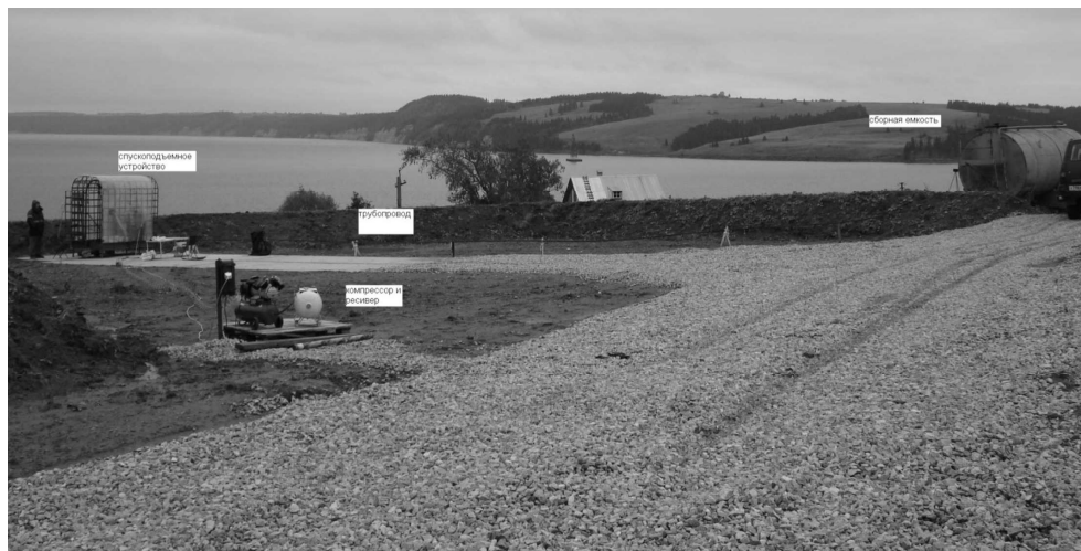
Рис.3. Схема расположения оборудования при откачке нефти с применением пневматического насоса
