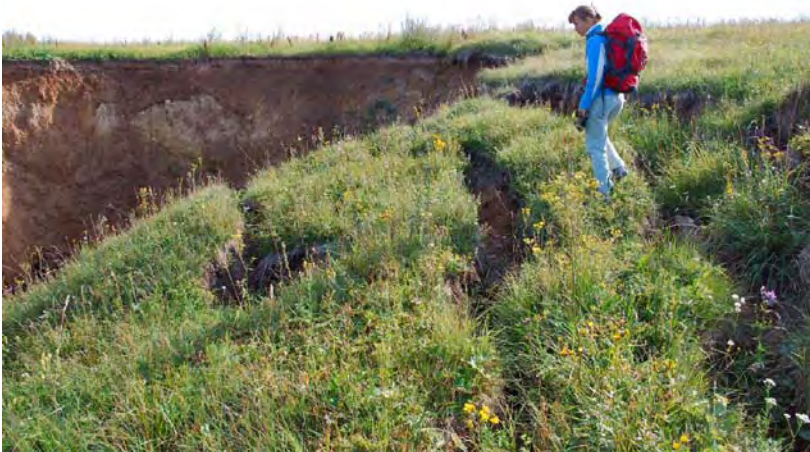
Рис. 10. Проседание северного края и образование трещин в борту провала в 2009 г.
