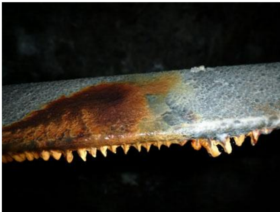
Рис. 12. Сталактиты на железных конструкциях в Камско-Устьинском гипсовом руднике
