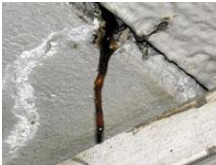
Рис. 5. Ожелезненные сталактиты длиной около 10 см в переходе под железной дорогой в Ла Неввиле (Швейцария)
