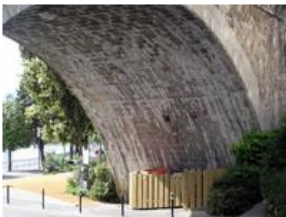
Рис. 6. Натечная кора на мосту в Монтре, Швейцария
