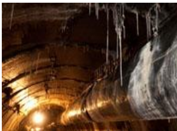
Рис. 11. Сталактиты в главном разгрузочном канализационном коллекторе г. Перми (фото О. Л. Есюнина)
