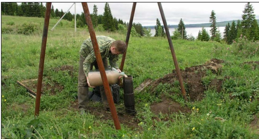
Рис. 4. Заливка культуры нефтеокисляющих бактерий в скважину
